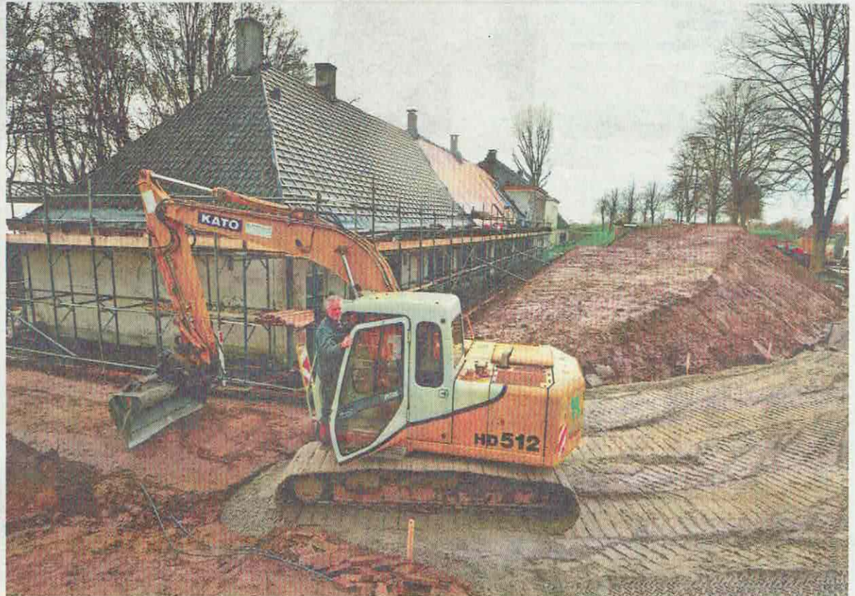
▲ Dragline-machinist Reinier van Meijeren maakt de verlaagde toegangsweg vlak. Erachter is de geschoonde verdedigingswal en de vleugel met manschappenverblijven zichtbaar. FOTO PIM MUL
